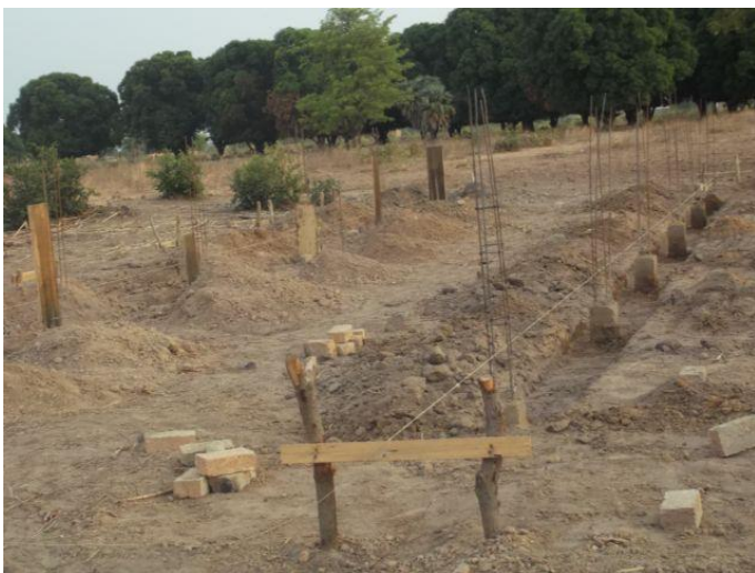
Fondations Bâtiment Salle de Classe (1 pièce) + Crèche (3 pièces)
